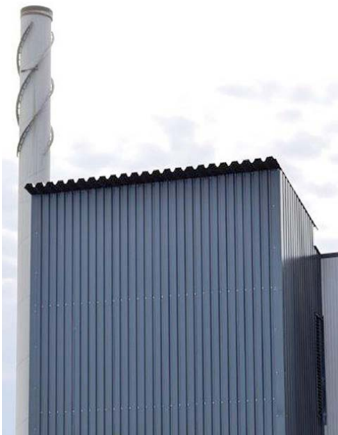
Abb. 21: Außenlager (70 t) aus zwei Gewebesilos mit Einhausung (Bildquelle: allg. Silotec)
